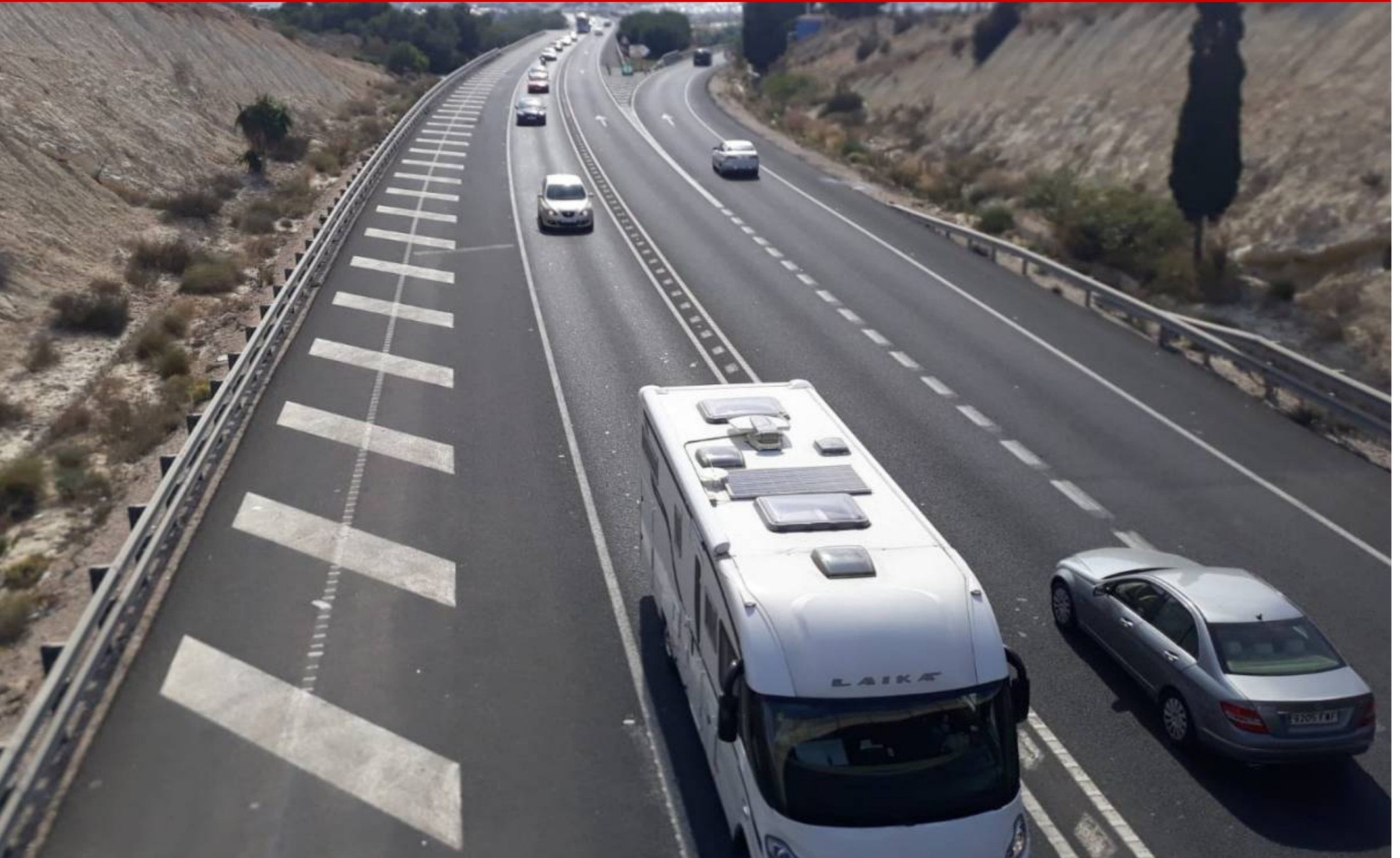
Carretera Nacional N-338
